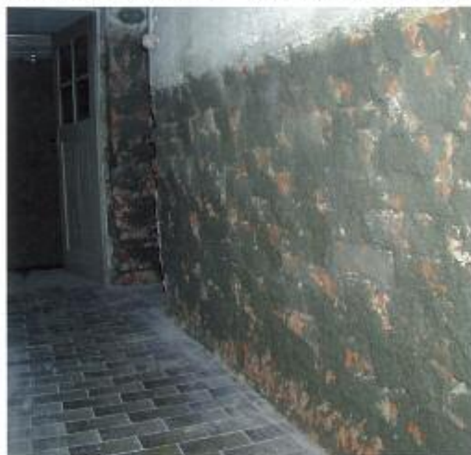
Ein faserverstärkter Spritzbewurf bildet die Haftbrücke zwischen feuchter Kellerwand und Sperrschicht
