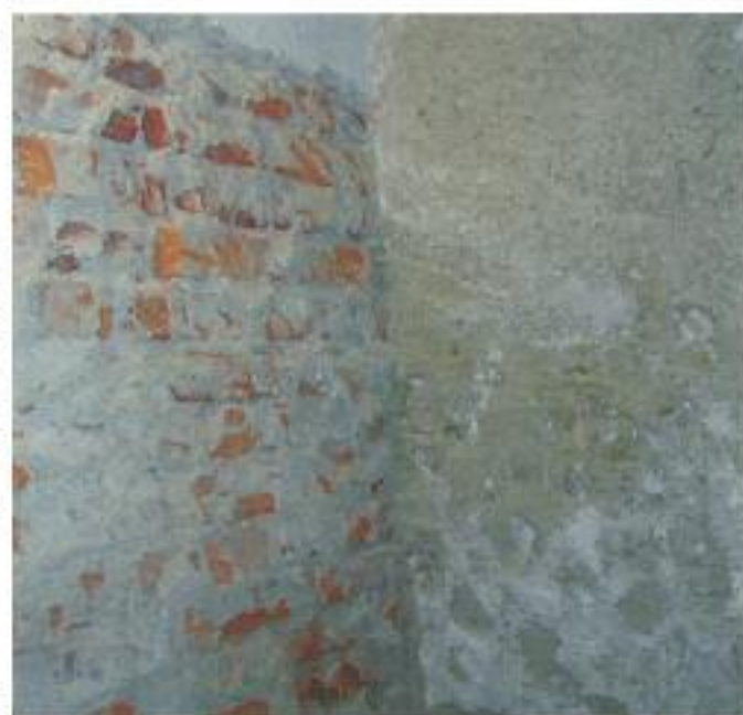
Der alte Putz muss vor der Innenisolierung gründlich entfernt werden
